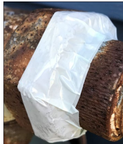
Método 1: Primeiro aplique no diâmetro maior e depois aperte o adesivo restante com a mão
