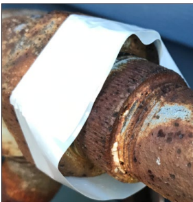
Método 1: Primeiro aplique no diâmetro maior e depois aperte o adesivo restante com a mão
